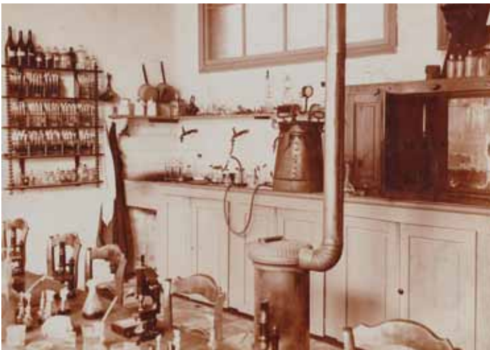
Laboratorium voor microbiologie met autoclaaf, broedstof, microscopen en gasaansluiting in de brouwerijschool Sint-Lieven in Gent, 1892. Schoolarchief Sint-Lievenscollege, Gent.
